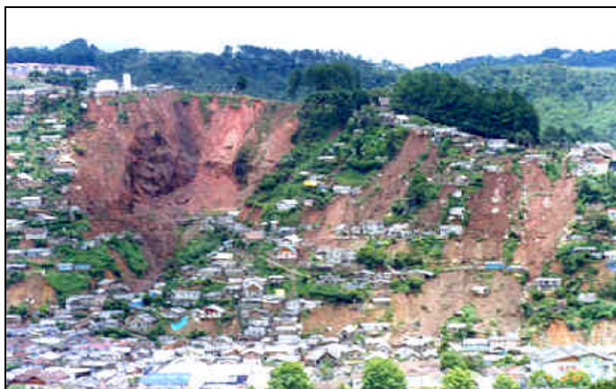
Figura 02. Deslizando no morro do Britador, cidade de Campos do Jordão, Estado de São Paulo, em janeiro de 2000. Como consequência desse episódio pluviométrico de mais de 500 mm acumulado em uma semana, cerca de 450 casas foram destruídas, dezenas de pessoas feridas e dez mortes foram registradas (arquivo DIGEO / IPT). Extraído de Nogueira (2002).
