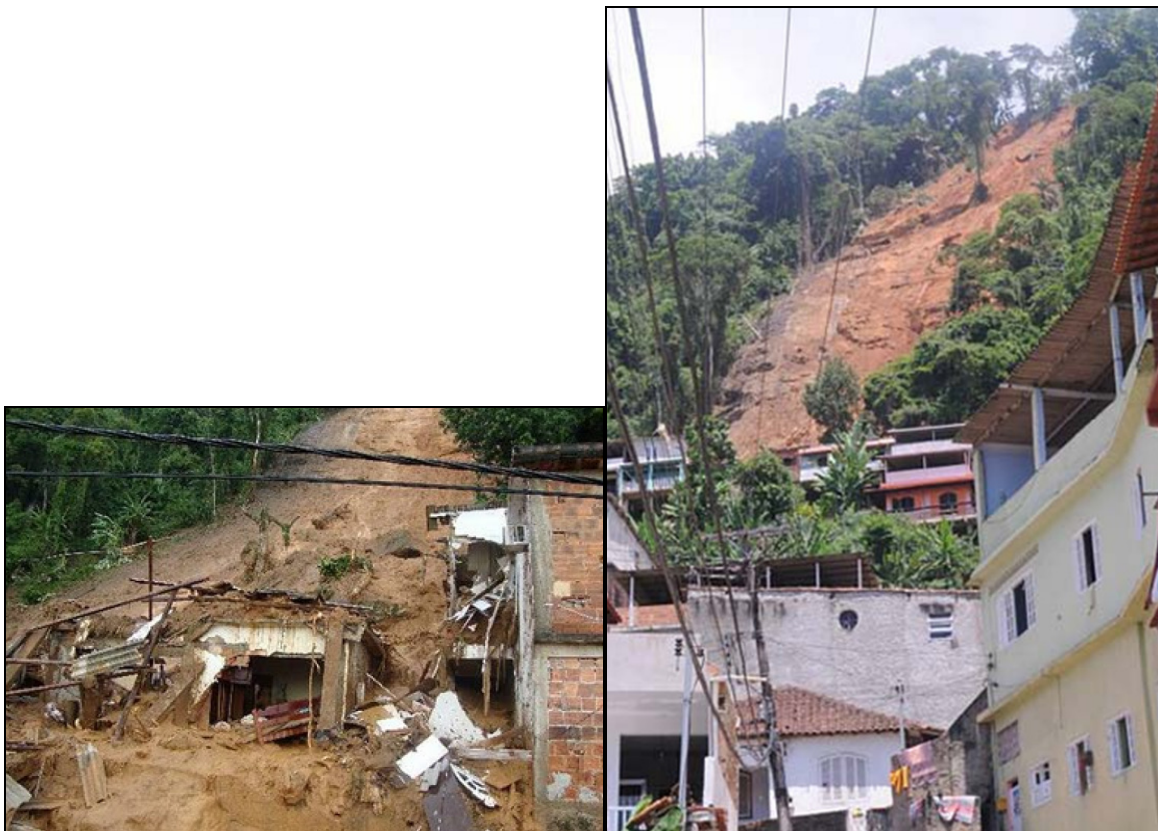
Figura 05. Morro da Carioca, cidade de Angra dos Reis, Estado do Rio de Janeiro (janeiro de 2010). Deslizamento translacional de solo, tipo superficial. Extraído de Bressani (2013).
