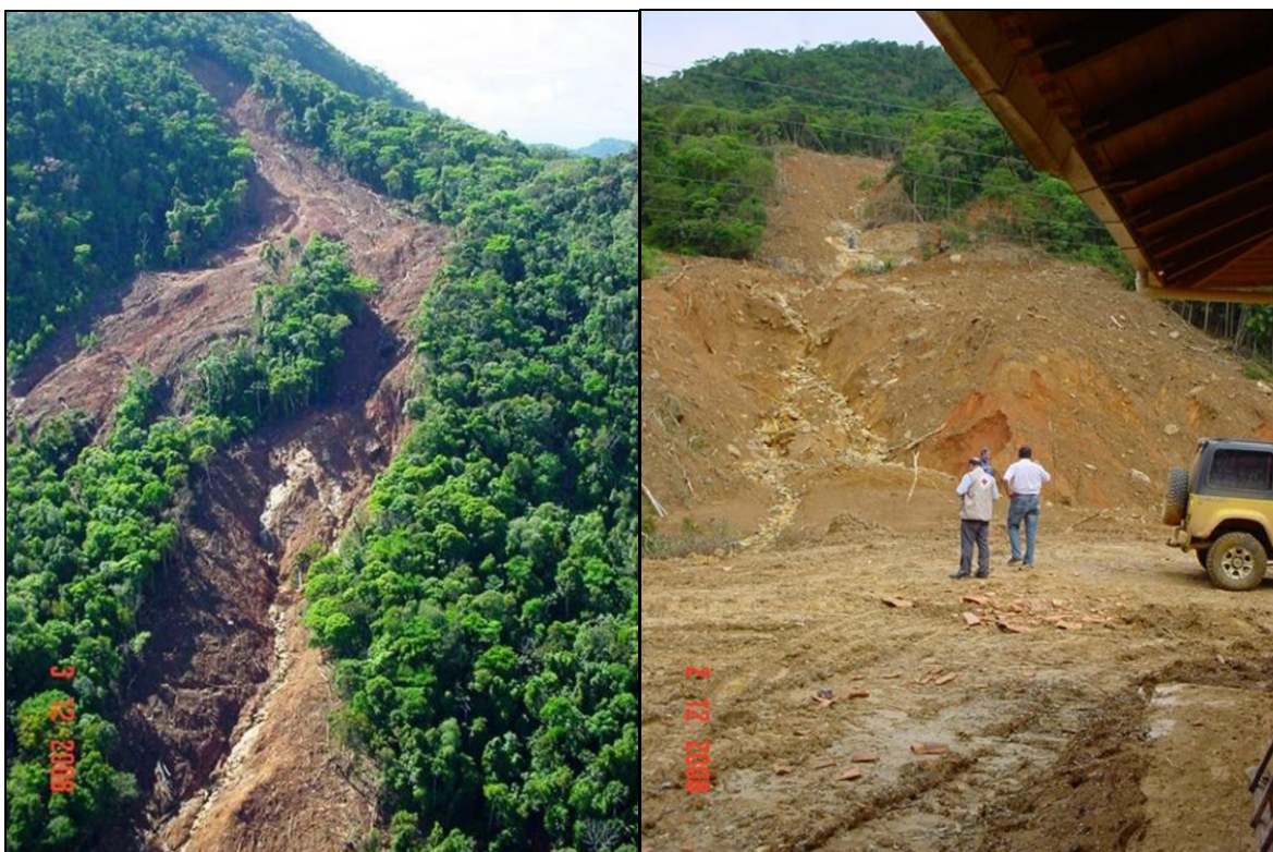
Figura 08. Deslizamento na cidade de Gaspar, estado de Santa Catarina. Extraído de Bressani (2013).
