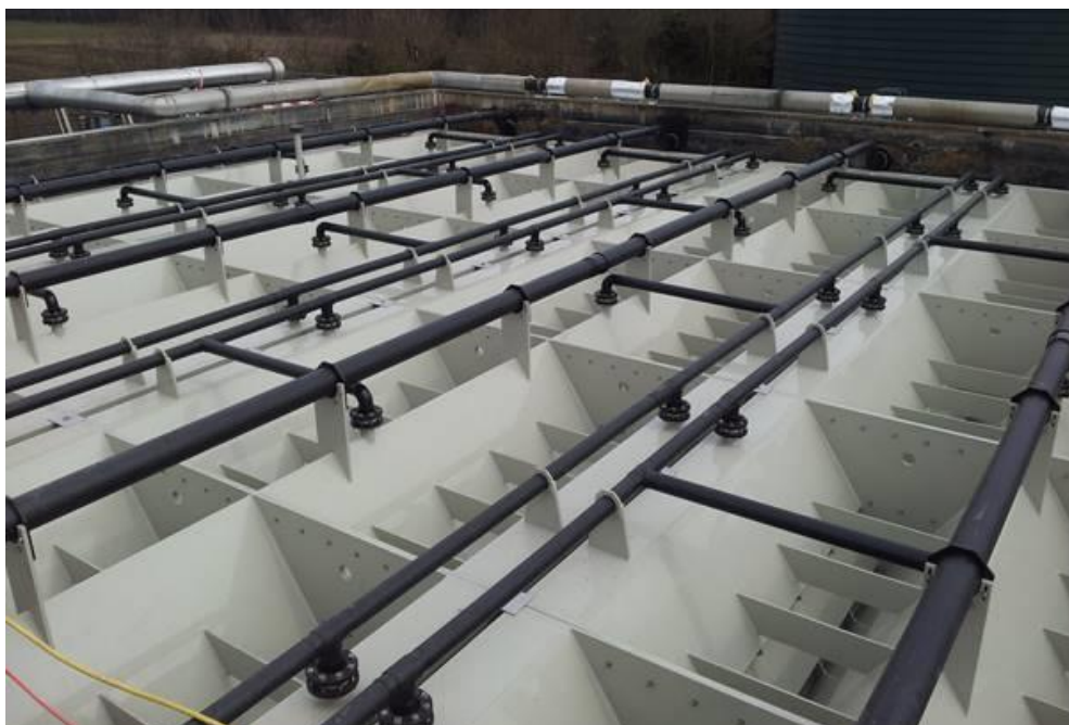
Figura 6: Reator UASB em chapas de polipropileno. Fonte: Catálogo Hydrothane.
