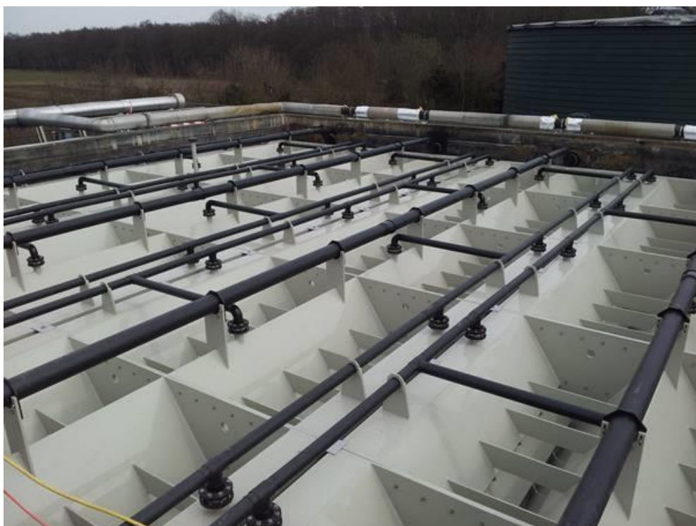
Figura 5: Reator UASB em chapas de polipropileno. Fonte: Catálogo Hidrothane.
