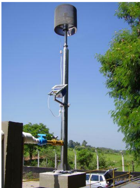
Figura 9: Flare de chama aparente fabricado e fornecido pela Combustec. Fonte: Catálogo técnico da empresa Combustec.
