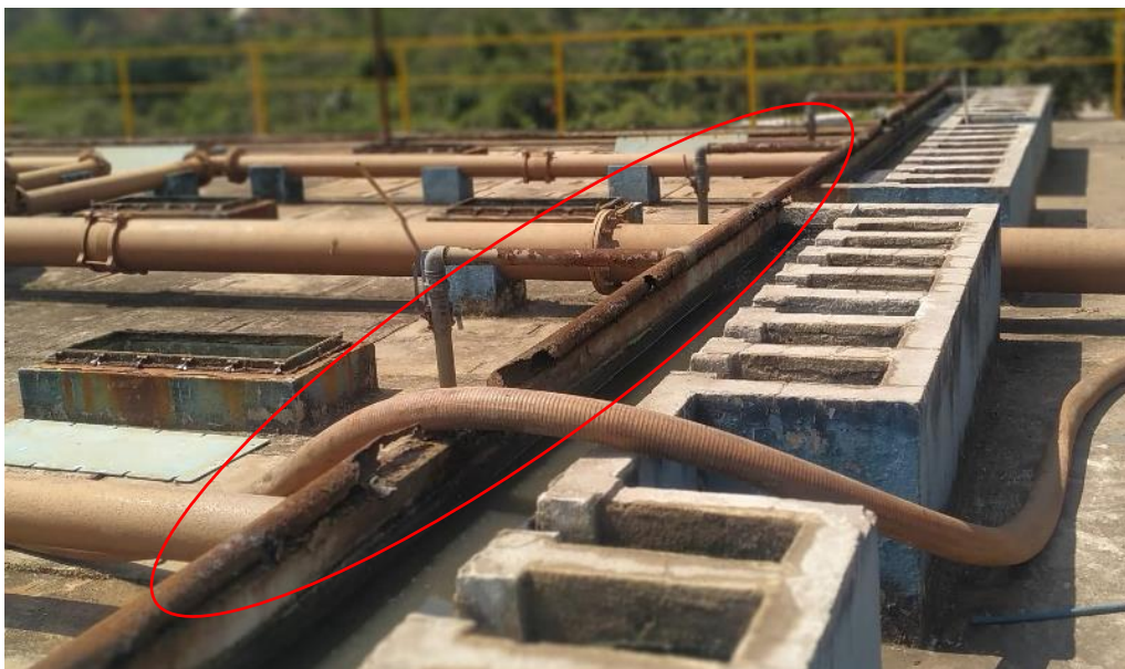
Figura 7: Tubulação de coleta do biogás da ETE de Itabirito-MG, fabricada em aço galvanizado, estando totalmente corroída. Fonte: Acervo do autor.
