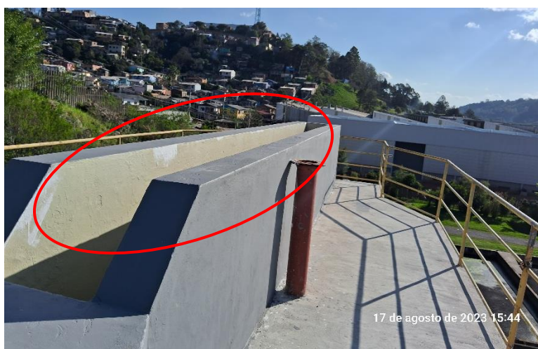
Figura 1: Canal de concreto no início da unidade de tratamento preliminar (desarenação), da ETE Canyon.
