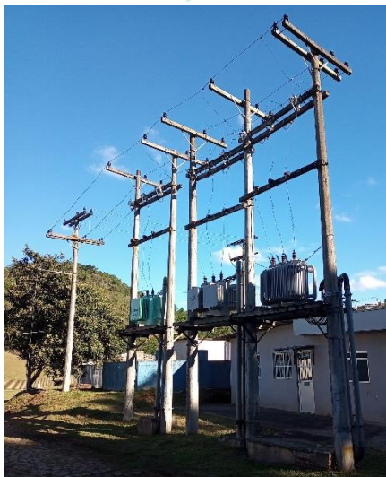
Figura 9 – Plataformas dos transformadores.
