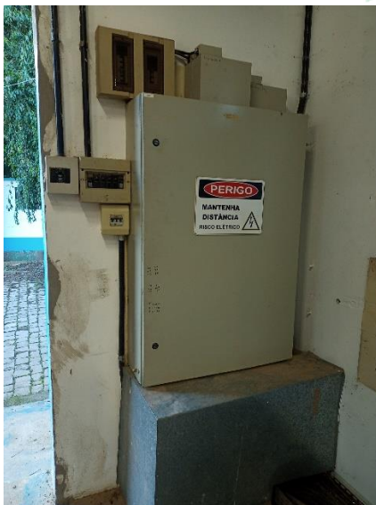
Figura 11 (à esquerda) – QGBT ao lado da porta de entrada da Casa de Bombas.
