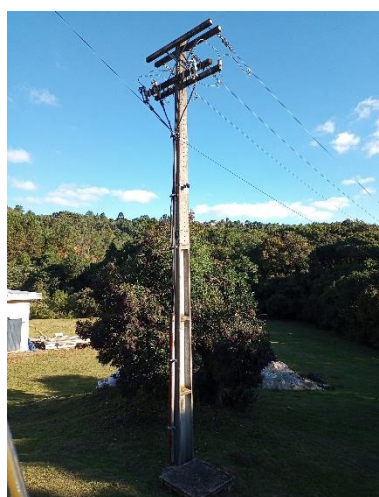
Figura 4 – Poste da tomada de energia (ponto de entrega da concessionária).
