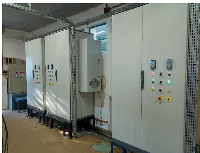
Figura 16 – Painéis de comando e acionamento dos motores.
