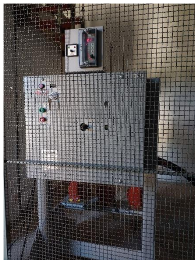
Figura 7 – Disjuntor geral de MT e relé de proteção.
