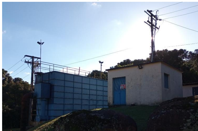
Figura 5 – Poste da tomada de energia (à esquerda) e cabine de medição (à direita).
