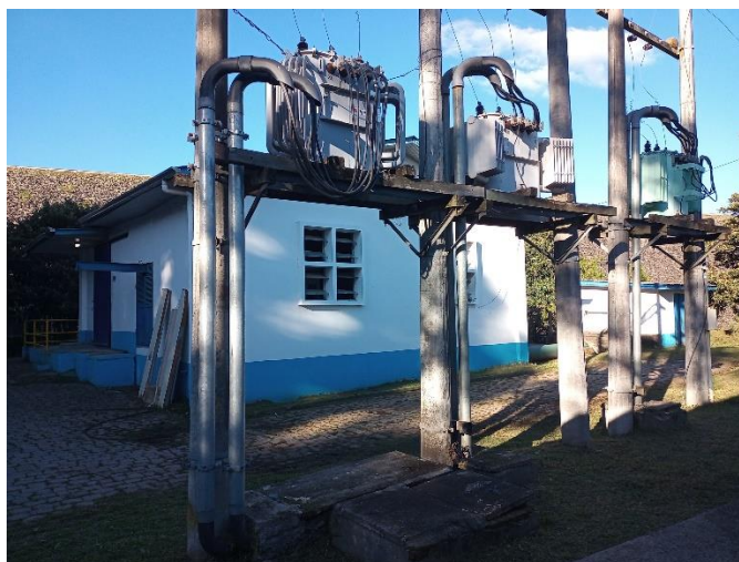
Figura 10 – Ramais de BT entre os transformadores e a Casa de Bombas (ao fundo).
