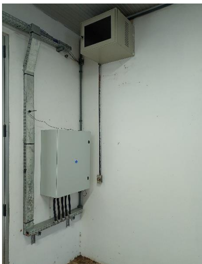
Figura 19 – Painel do CLP (embaixo) e Switch (no alto), para monitoramento remoto da estação.
