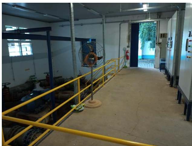
Figura 13 – Casa de Bombas: QGBT (ao fundo), motores (à esquerda) e acionamentos (à direita).
