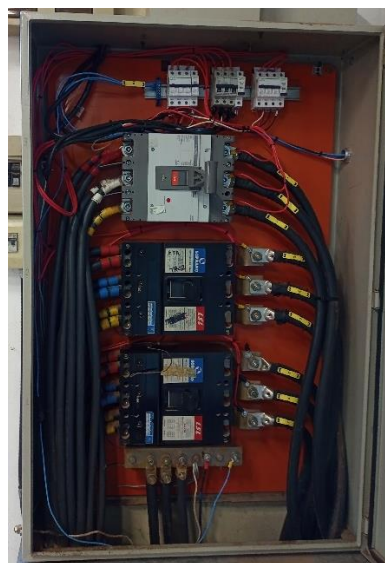
Figura 11 (à esquerda) – QGBT ao lado da porta de entrada da Casa de Bombas.
