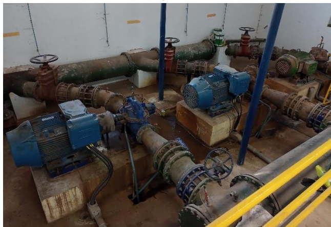
Figura 14 – Motores para bombeamento de água bruta.
